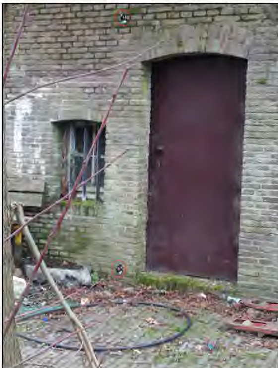
Figuur 4: Voorbeeldfoto positie prisma's (rood omcirkeld)
